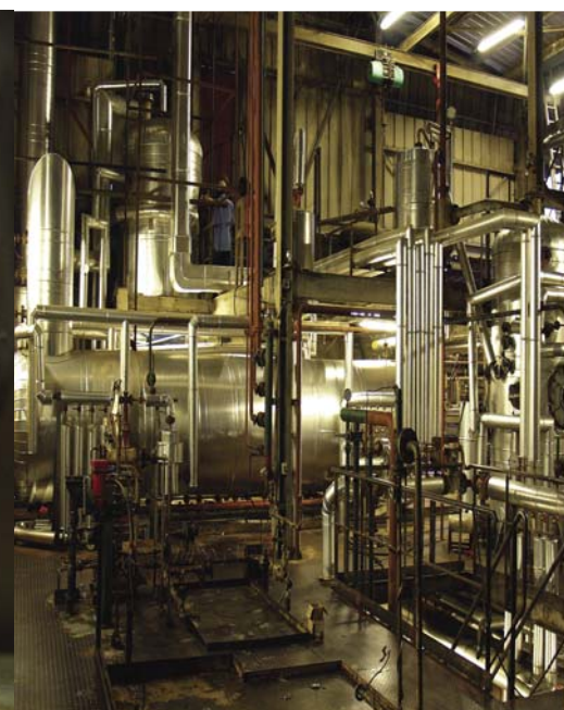
À partir de la gauche : les logements des employés au milieu des palmeraies à Makouké. Un savon de Marseille Pursavon sort des lignes de fabrication, prêt à être emballé ; l'an prochain, Siat Gabon lancera un savon de toilette haut de gamme élégamment conditionné. La raffinerie d'huile de palme après les récents travaux.
